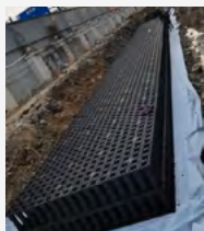
地下雨水蒐集池施工作業
